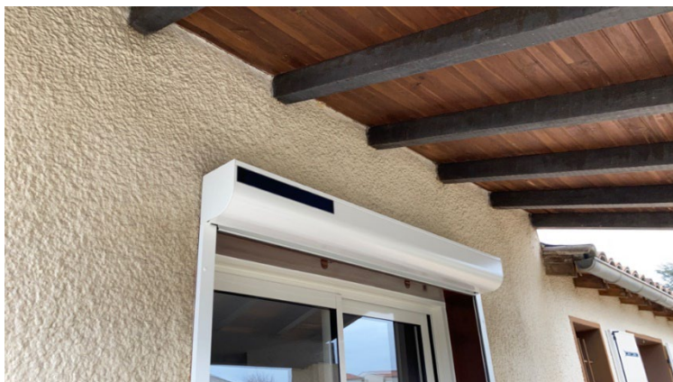
Les panneaux sont positionnés sous les appentis, pas d'exposition au soleil = NON CONFORME
